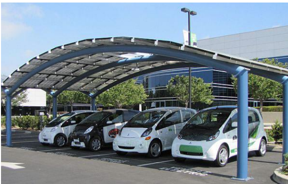
Rys. 2. Rozwiązanie parkingu z panelami fotowoltaicznymi [7]
